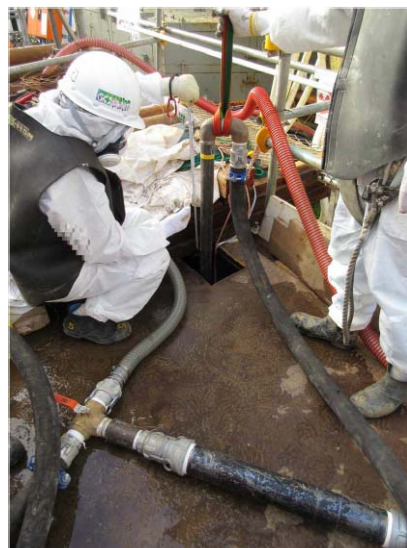
2号機海水配管トレンチ 開削ダクト間詰め充填作業の様子
