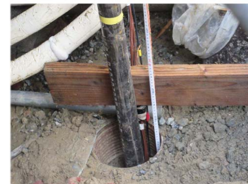
充填孔付近の様子
