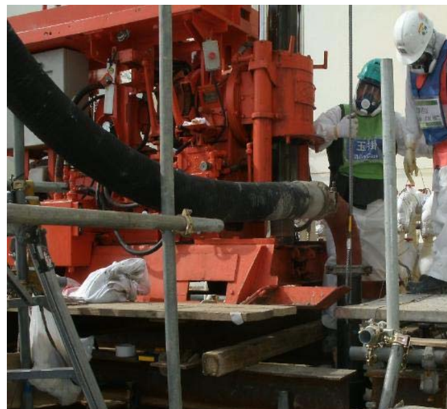
2号機海水配管トレンチ 立坑A間詰め充填状況
