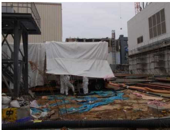
(当該配電盤の外観：カバーが掛けられている。)
