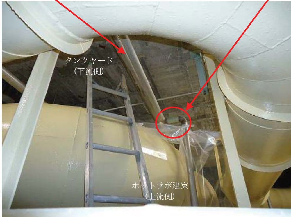
C トレンチ内外観
