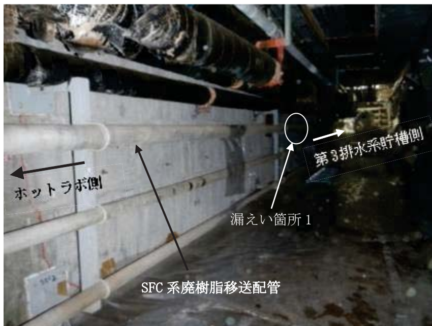
(2) C トレンチ内の状況
