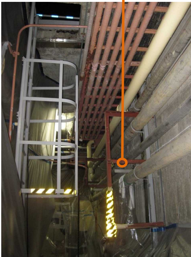
C トレンチ内部
